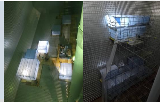
Tent Setup inside LNG Cargo Tank
