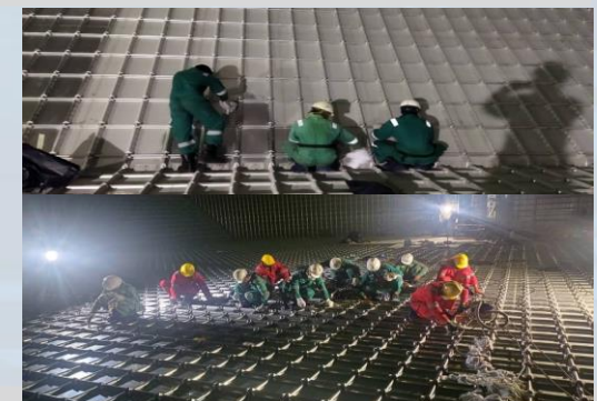
LNG Cargo Tank Cleaning
